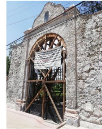
Retiro de aplanado
