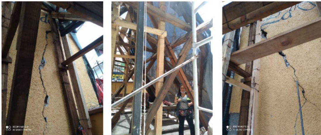
Suministro y colocación de apuntalamiento a base de polines y barrotes de madera de pino
