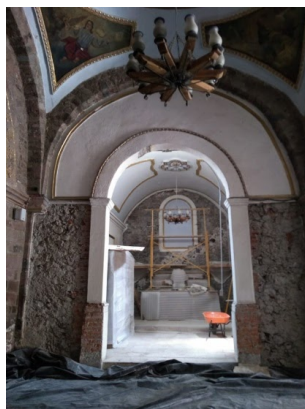
Inyección de grietas
