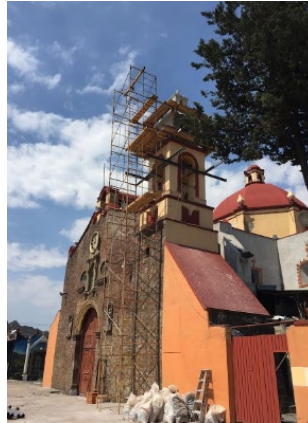
Trabajos de consolidación de torre campanario
