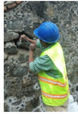
Retiro de mampostería
