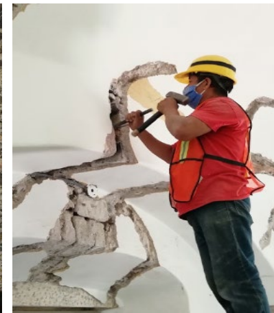
Liberación de grietas
