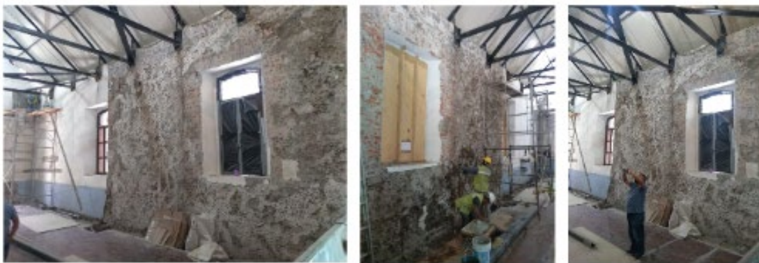
Retiro de aplanado existente en muro de mampostería
