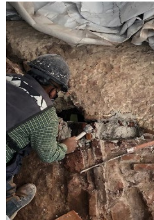
Consolidación de mampostería
