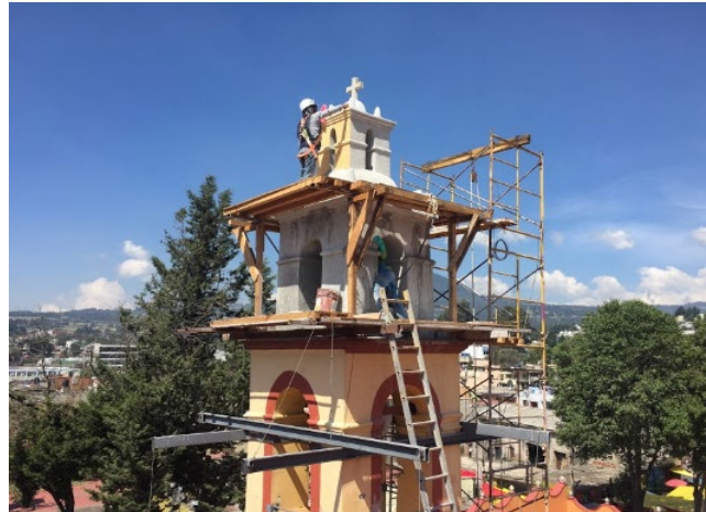
Trabajos de consolidación de torre campanario
