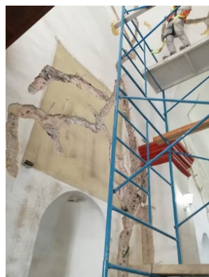
Liberación de grietas
